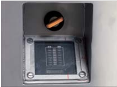
Versenkter Schlüsselschalter und Entladewächter
